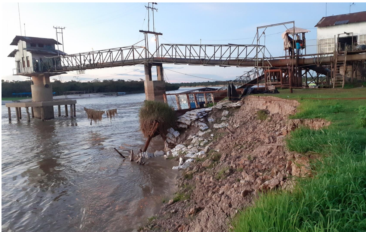
Bases del Punto de Captacion dañadas y en riesgo por la erosion e inundacion presente en la zona
